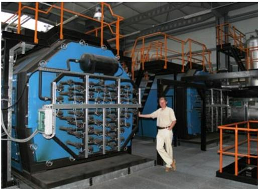
Dampfkessel mit Abreinigung 32 barü
